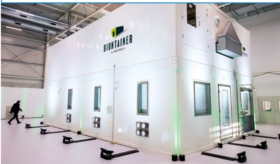
Ein mobiler, aus mehreren Containern zusammengesetzter »Biontainer« in der Produktionshalle des Pharmaunternehmens BioNTech in Marburg.
